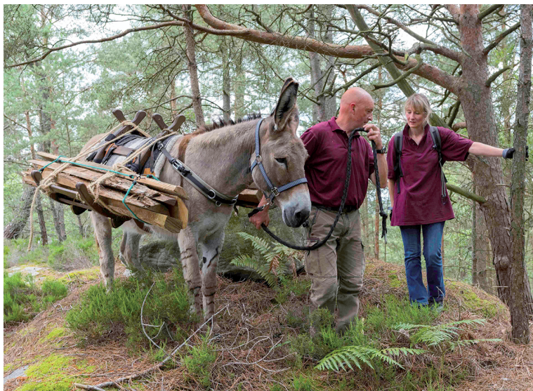
L'âne Rodéo, son ânier Michel Brun et sa femme, transportant des dosses pour les travaux anti-érosion du site des Toits-du-Laris sur le sentier n° 16.
