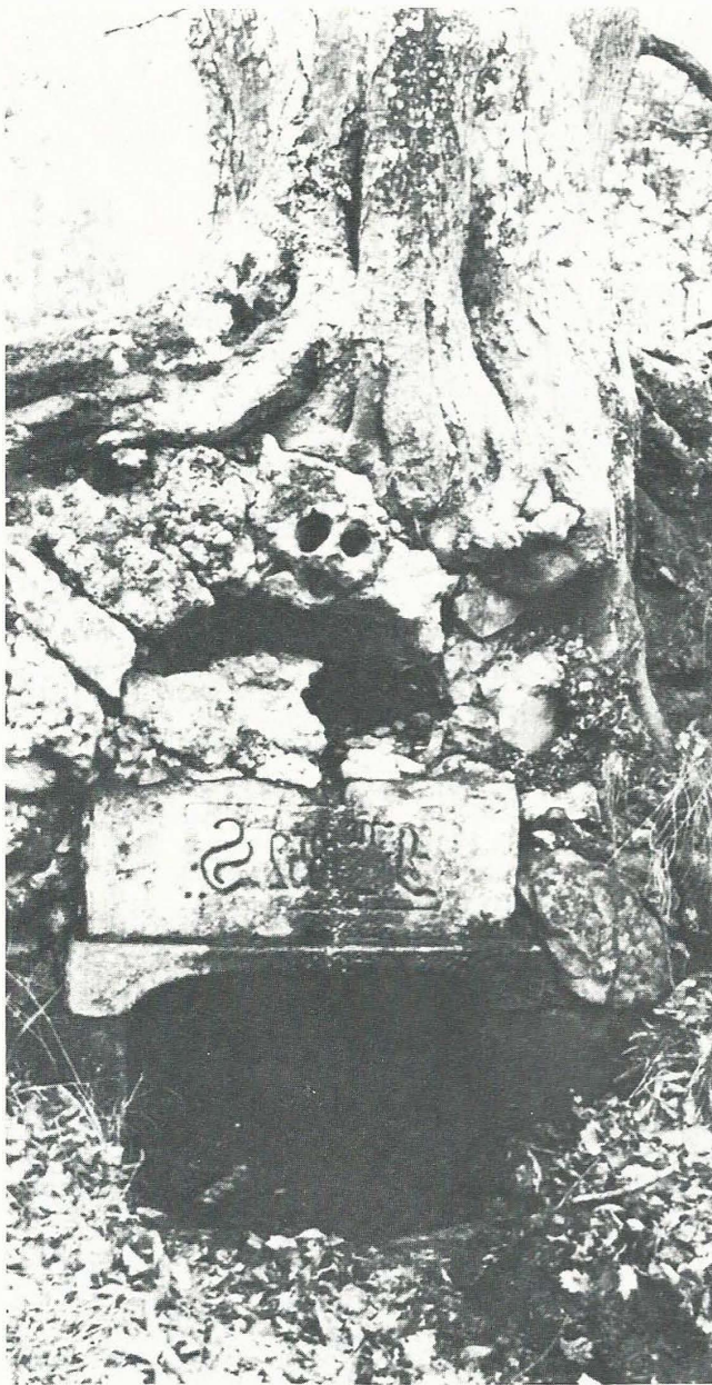
La Fontaine Sanguinède (Hauteurs de la Solle). Une double curiosité typiquement fontainebleaudienne : creusée, aménagée et architecturée par Denecourt en 1852, dédiée au bienfaiteur de son œuvre des sentiers-promenades Sanguinède, orfèvre à Paris, cette fontaine a eu l'arc de sa voute enserré par les racines tantaculaires d'un gros hêtre que cette situation n'a pas gêné dans sa croissance depuis plus d'un siècle. (Photo Jean-Robert MASSON).
